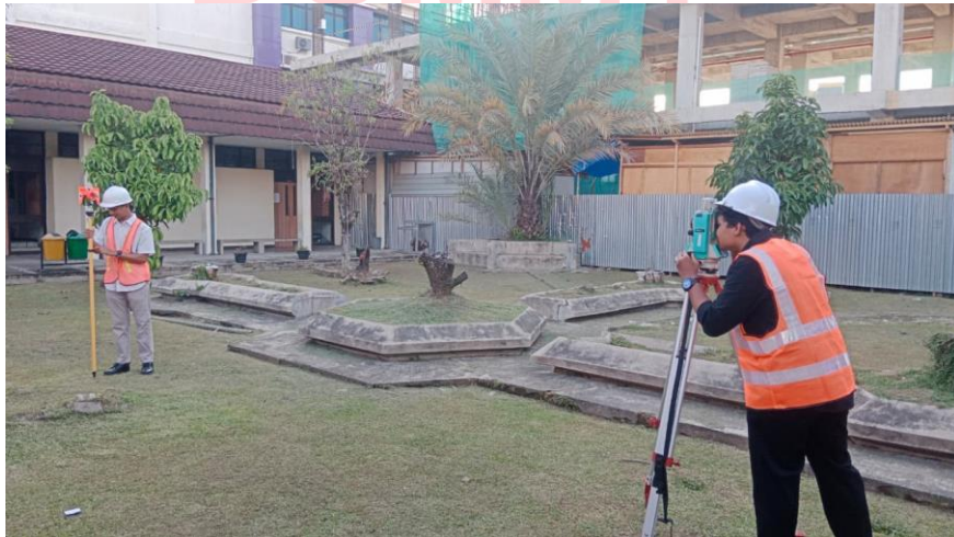
Gambar 6. Pengukuran dengan Total Station
